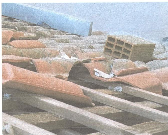
Figura 04 - Detalhe do telhado visto a partir da varanda traseira da casa com avarias
