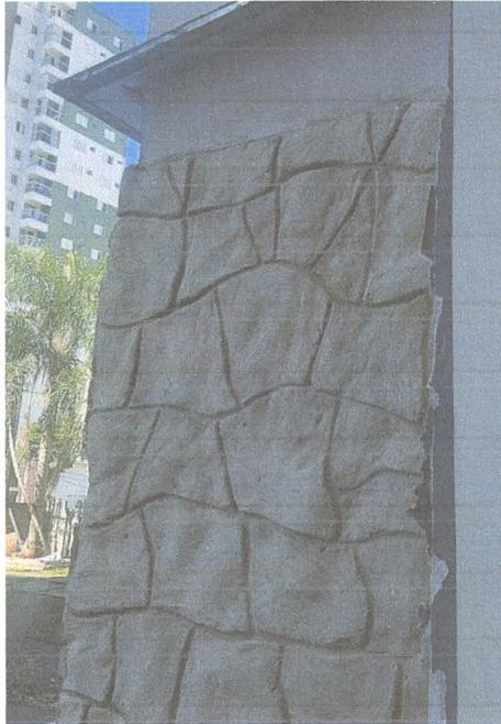
Figura 03 e 04 - Detalhe das paredes e do processo de restauro reboco decorativo
