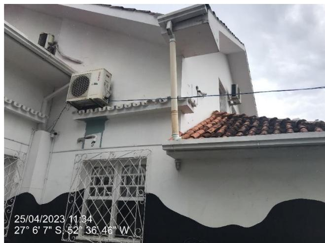
Figura 36 -Vista calhas em chapa de aço pintada
