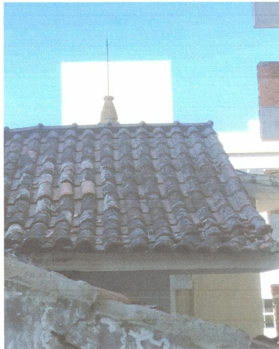
Figura 02 - Telhado visto a partir da varanda traseira da Casa , sem troca ou quebra, mantidas as características originais
