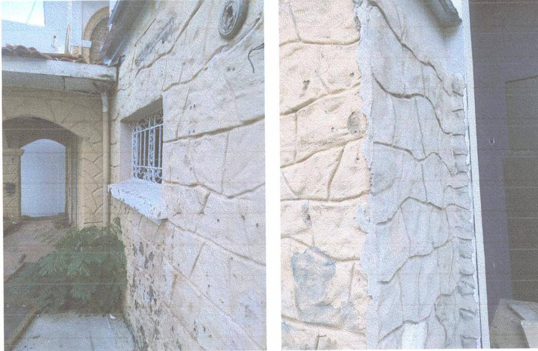
Figura 01 e 02 - Vista da parede lateral da casa e detalhe do processo de restauro iniciado
