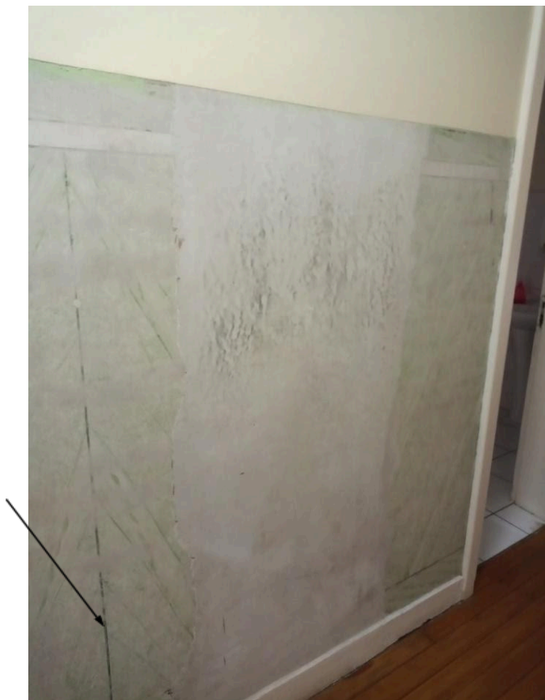
Figura nº 13 - Intervenção que resultou na descaracterização da escaiola
