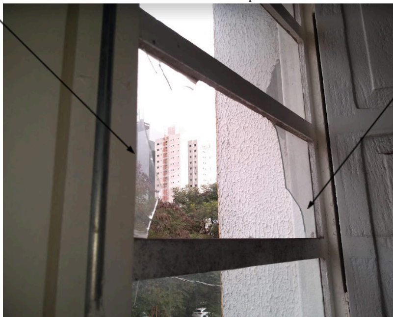
Figura nº 24 - Janela na sala de Reserva Técnica com o vidro quebrado
