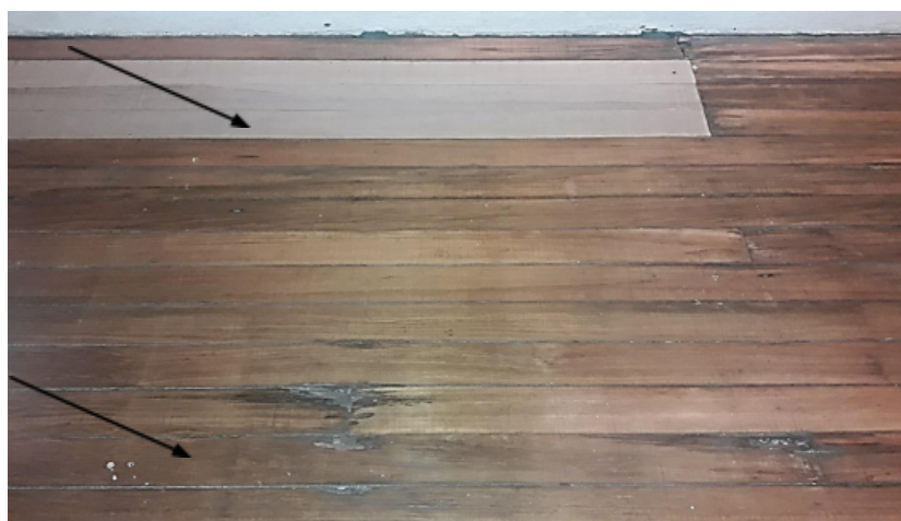
Figura nº 17 - Assoalho com presença de desgastes e deterioração
