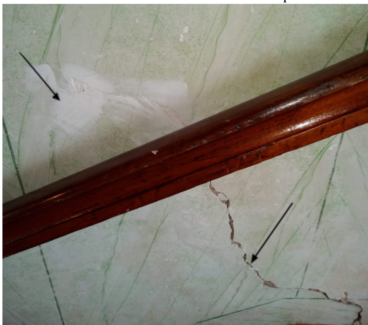
Figura nº 14 - Rachadura na escaiola localizada no final do primeiro lance de escadas
