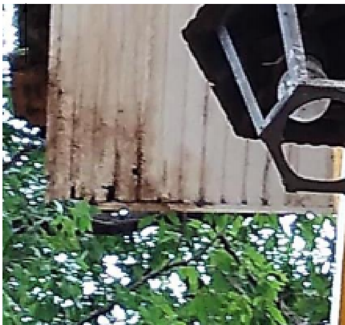
Figura nº 10 - Aba e espelhos deterioradas pela chuva
