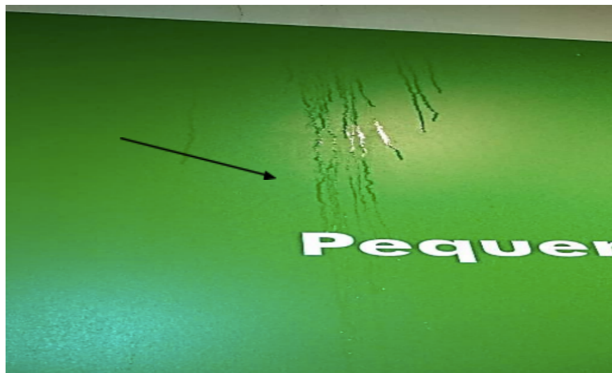
Figura nº 08 - Infiltração em sala expositiva do piso inferior
