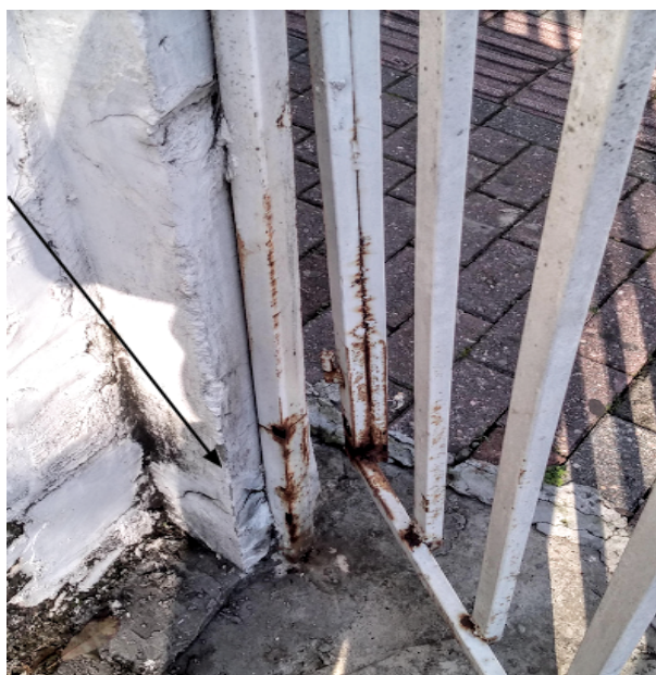
Nota: Portão de acesso à rampa quebrado com a presença de corrosão. Fonte: Foto de Gustavo Andre Glienke Feyh.
