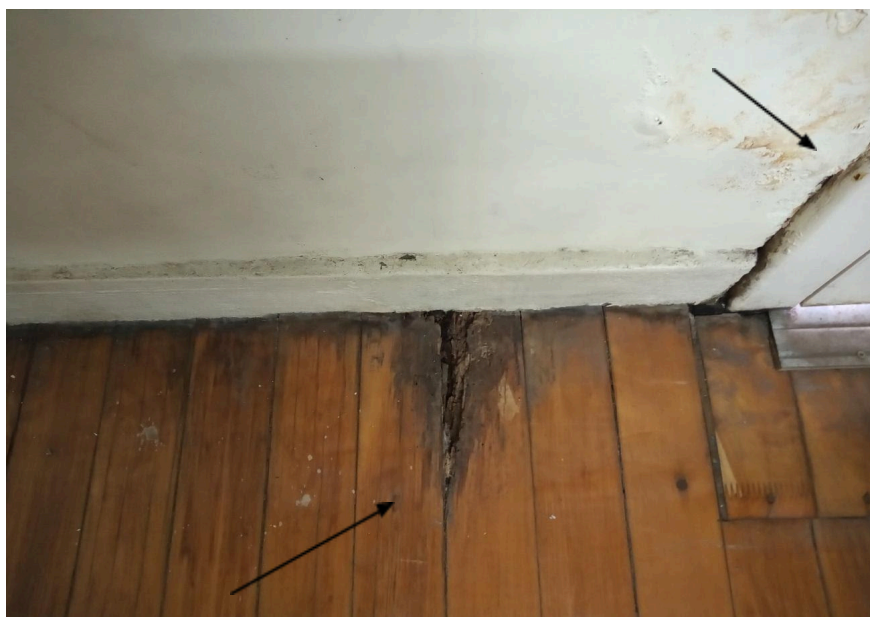
Figura nº 17 - Assoalho com presença de desgastes e deterioração
